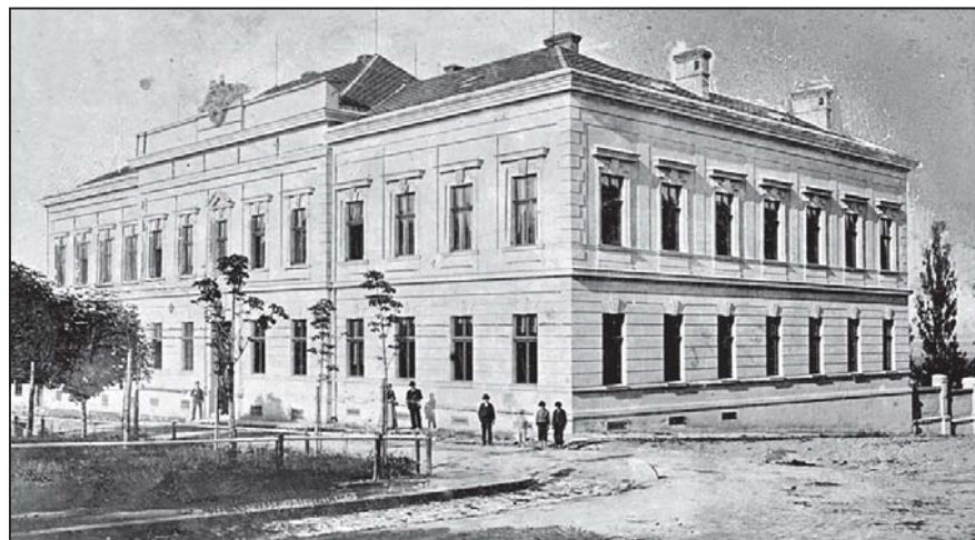
Takto kdysi vypadala budova, kterou nyní čeká oprava za osmnáct milionů korun.
