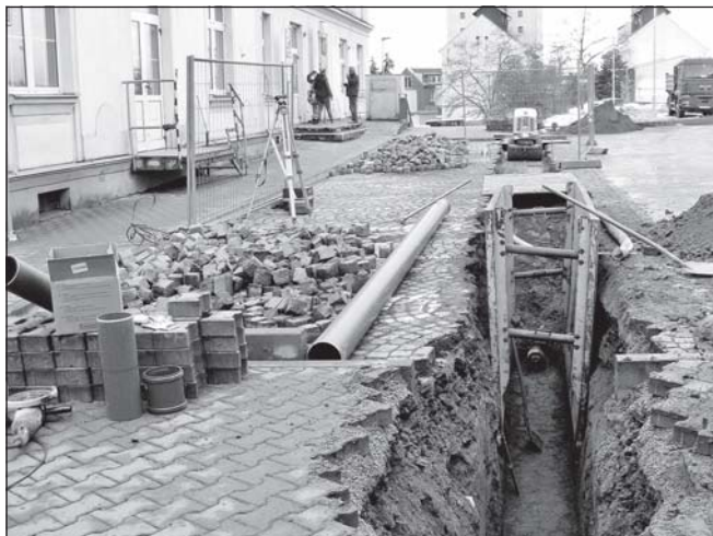
Stavební práce před budovou pošty – začátkem prosince před sněhovou nadílkou. Foto: František Čábel
