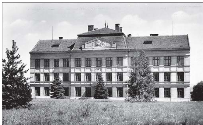
Budova gymnázia kdysi...
