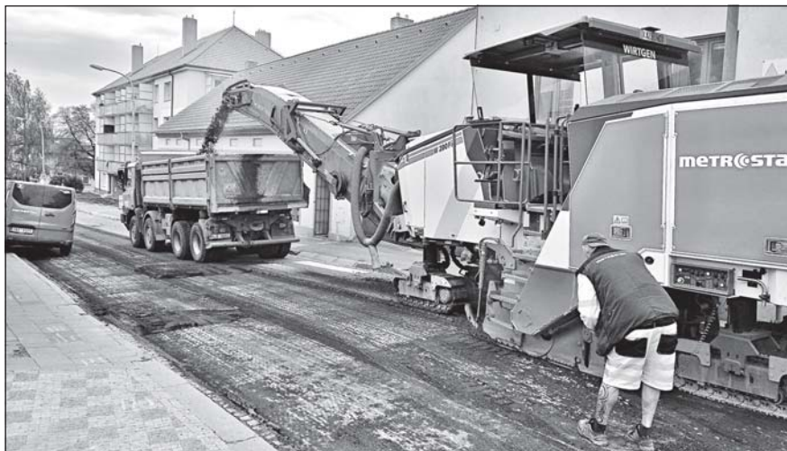
Začátkem května se rozběhly práce také v ulici Janáčkova.
