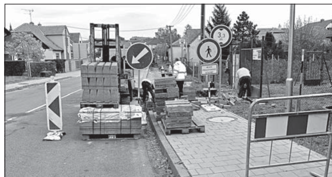
Práce spojené s rozsáhlou opravou chodníku zajistila firma z Lukova.
