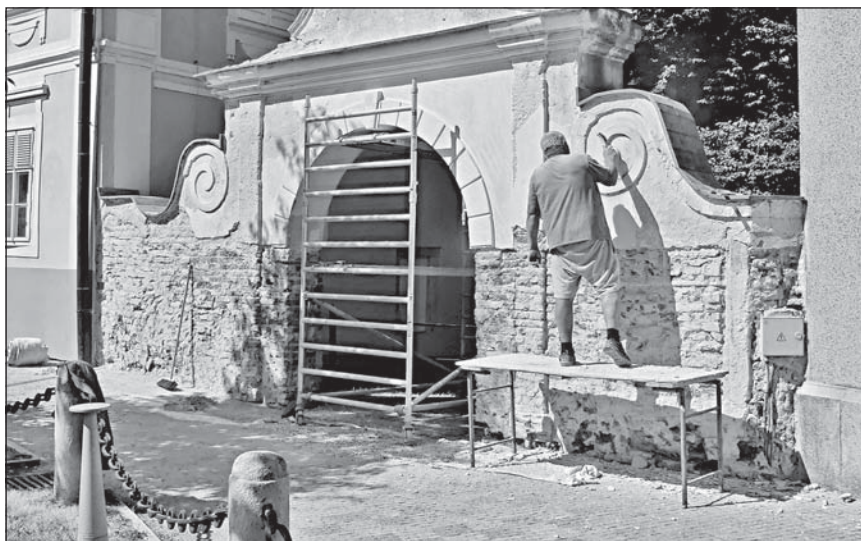
V polovině července začaly práce spojené s obnovou vstupní brány a zdi malého zámeckého parku.
