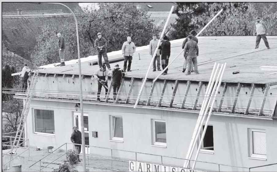
První brigáda spojená s opravou střechy se uskutečnila druhou listopadovou sobotu.
